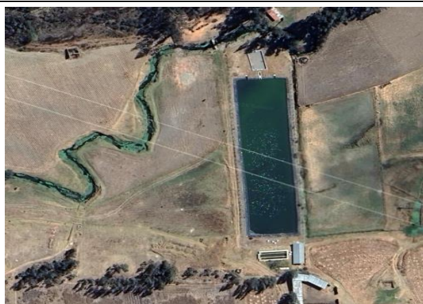
Vista de la planta de tratamiento de aguas residuales del distrito Daniel Hernández.
