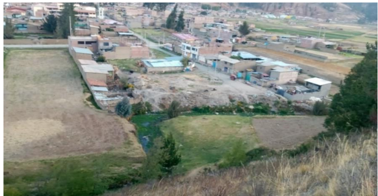
Fotografía 5: Se observa la proximidad de las edificaciones al cauce del río Opamayo.
