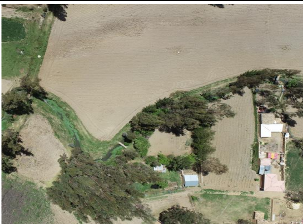
Se observa la cercanía de las edificaciones al cauce del río Opamayo en el tramo Pampas – Daniel Hernández.
