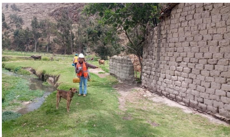
Fotografía 7: Vivienda de adobe construida al borde del cauce del río Opamayo.
