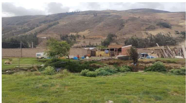
Fotografía 6: Se observa la proximidad de viviendas al cauce del río Opamayo.
