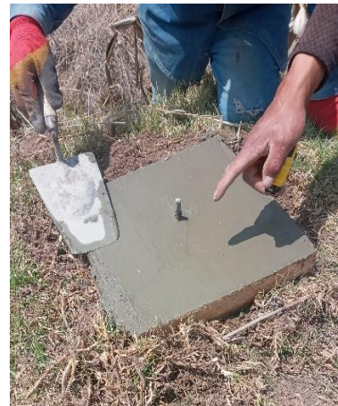
Colocado de los aceros corrugados en los BMs.
