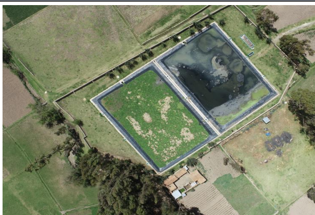
Vista de la planta de tratamiento de aguas residuales del distrito Acraquia.
