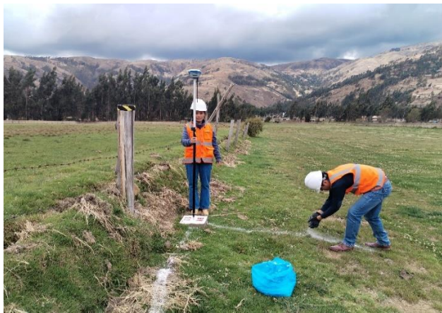
Marcado de BM-21 con yeso para su fácil identificación con el dron durante el vuelo.
