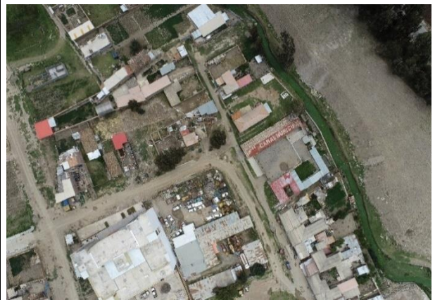
Se observa la cercanía de las edificaciones al cauce del río Opamayo en el distrito Pampas.
