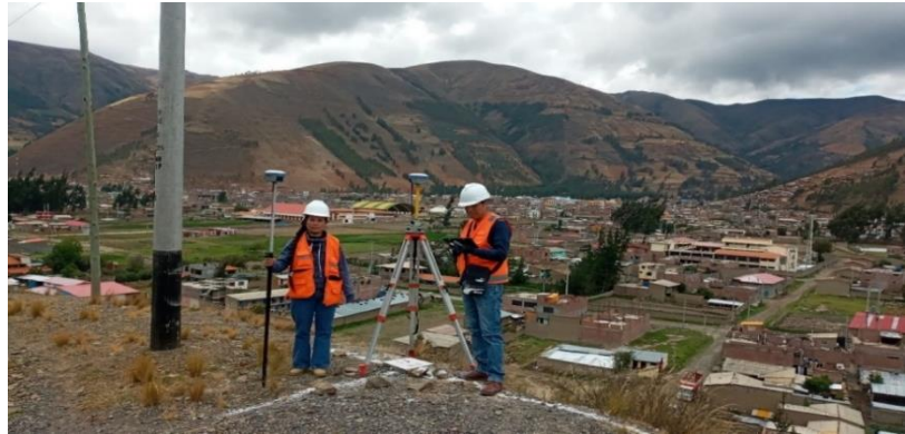
Fotografía 21: Configurando los equipos para así obtener datos topográficos precisos en tiempo real (Receptor GNSS diferencial uno estacionado y uno móvil más tablet).
