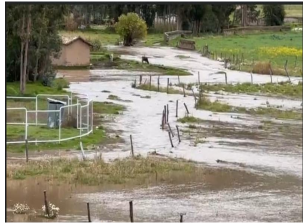
Aumento del caudal del rio Opamayo en la progresiva 13+400.0, provocado por constantes lluvias.
