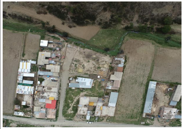
Se observa la cercanía de las edificaciones al cauce del río Opamayo en el tramo Ahuaycha – Pampas.
