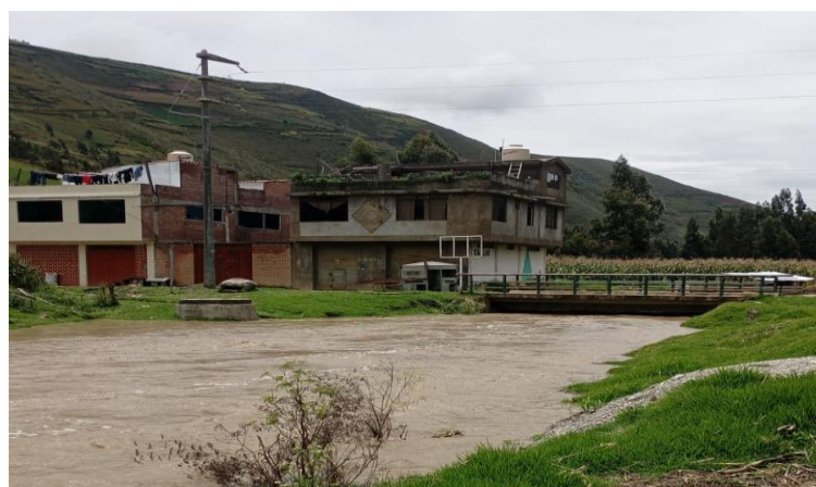
Fotografía 8: Vivienda construida al borde del cauce del río Opamayo.
