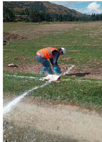
Marcado de BM-11 con yeso para su fácil identificación con el dron durante el vuelo.
