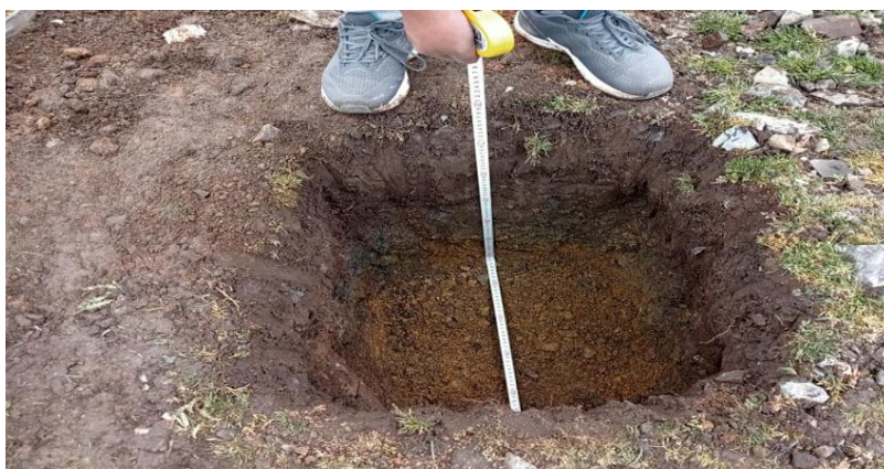
Fotografía 17: Excavación de 30 x 30 cm con profundidad de 50 cm para BMs.
