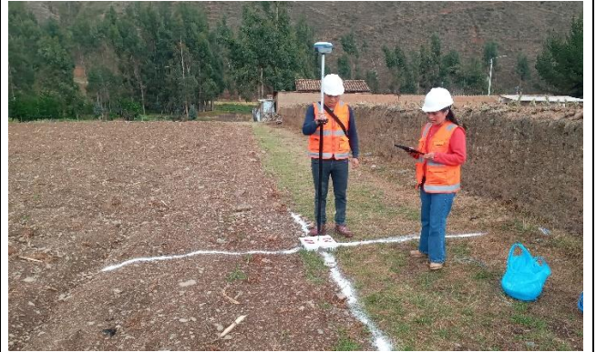
Marcado con yeso y verificación de coordenadas de los BMs con el receptor GNSS móvil que se encuentra conectada a la tablet para el registro.
