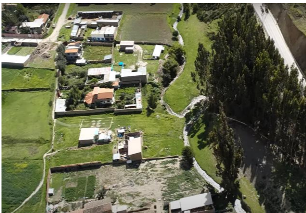
Se observa la cercanía de las edificaciones al cauce del río Opamayo en distrito Pampas.
