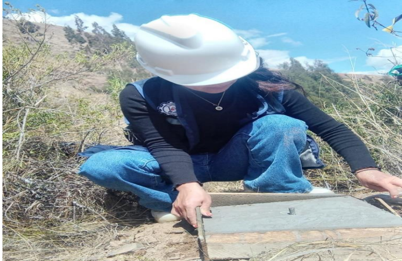
Fotografía 19: Desencofrado de BMs.
