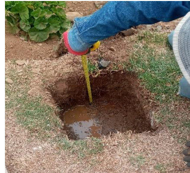
Excavación de BMs, dimensiones 0.40 m x 0.40 m x 0.40 m.
