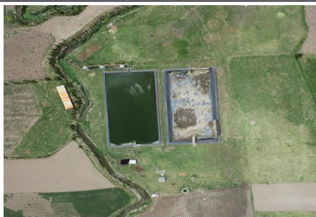
Vista de la planta de tratamiento de aguas residuales del distrito Ahuaycha.
