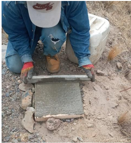
Encofrado y vaciado de concreto para BMs.
