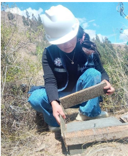
Desenfofrado de los BMs.
