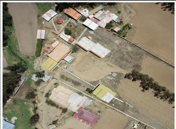
Se observa la cercanía de las edificaciones al cauce del río Opamayo en el distrito Daniel Hernández.
