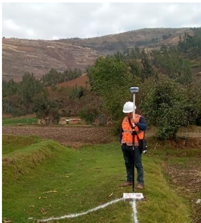
BM-04: Coordenadas UTM (E: 516968.579; N: 8633241.46), cota altimétrica: 3198.008 m s.n.m.
