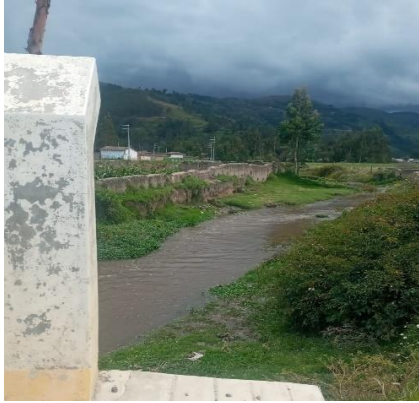
Aumento del caudal del rio Opamayo en la progresiva 15+040.0, provocado por constantes lluvias.
