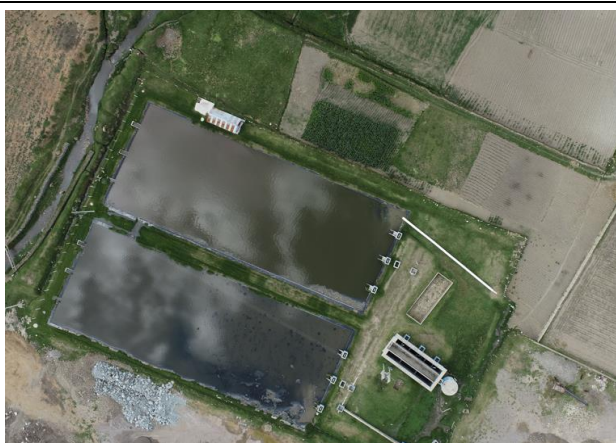
Vista de la planta de tratamiento de aguas residuales del distrito Pampas.
