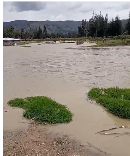
Aumento del caudal del rio Opamayo en la progresiva 2+980.00, provocado por constantes lluvias.
